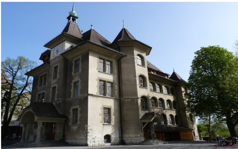
L'ancien collège de Nyon
